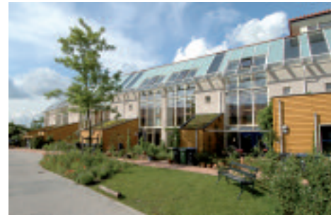
Photo © Y. Saint-Jours. Immeuble social dans le quartier Lanxmeer de Culemborg (Pays-Bas). Immeuble en béton cellulaire avec parement en briques de coquillages, chauffe-eau solaire, serre, toits végétalisés sur les appentis, bardage bois.
